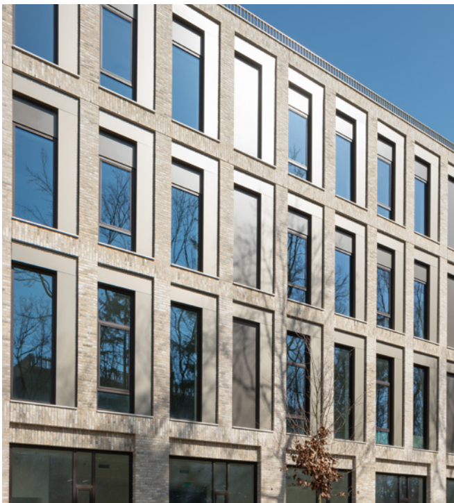
Die Fassade besteht aus vier Materialien: Backstein, Aluminium, Beton und Glas
